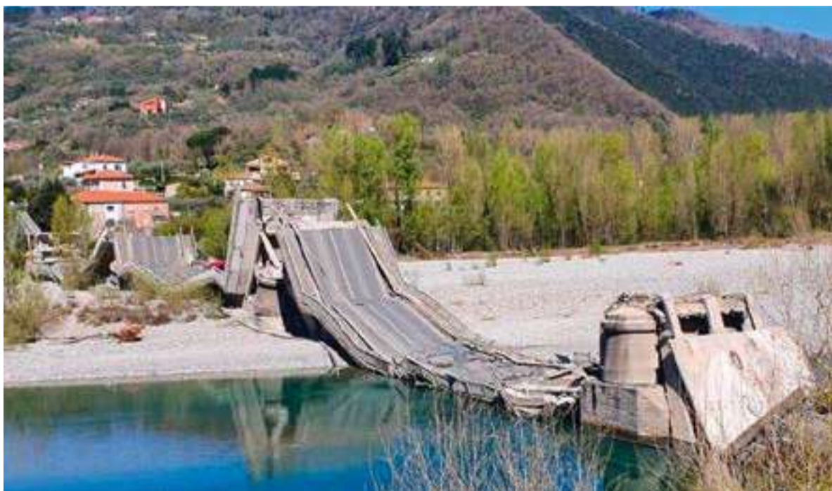
Il ponte di Albiano, sulla Statale 62, è crollato lo scorso 8 aprile causando solo due feriti lievi. Al momento si stanno svolgendo le indagini. Il ponte è stato costruito da Anas nel 1908. Distrutto durante la Seconda Guerra Mondiale, è stato ricostruito nel 1949. Nel corso degli anni, la gestione del ponte è passata poi dalla Prov. di Massa Carrara, fino al 2018, anno in cui è stata ripresa da Anas.
